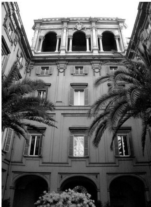
A palota belső homlokzata a loggiával
