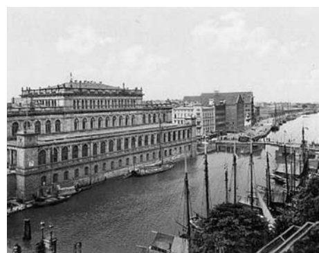
A tőzsde épülete
